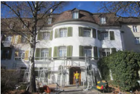
Beginn der Arbeiten an der Dach- und Fassadenrenovation im Oktober.
