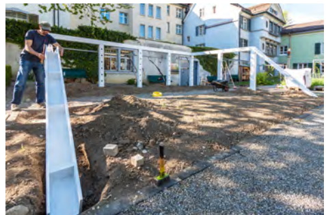
Museumsgärtner Marcel Sprenger beim anspruchsvollen Aufbau der «Hochbeetbahn».
